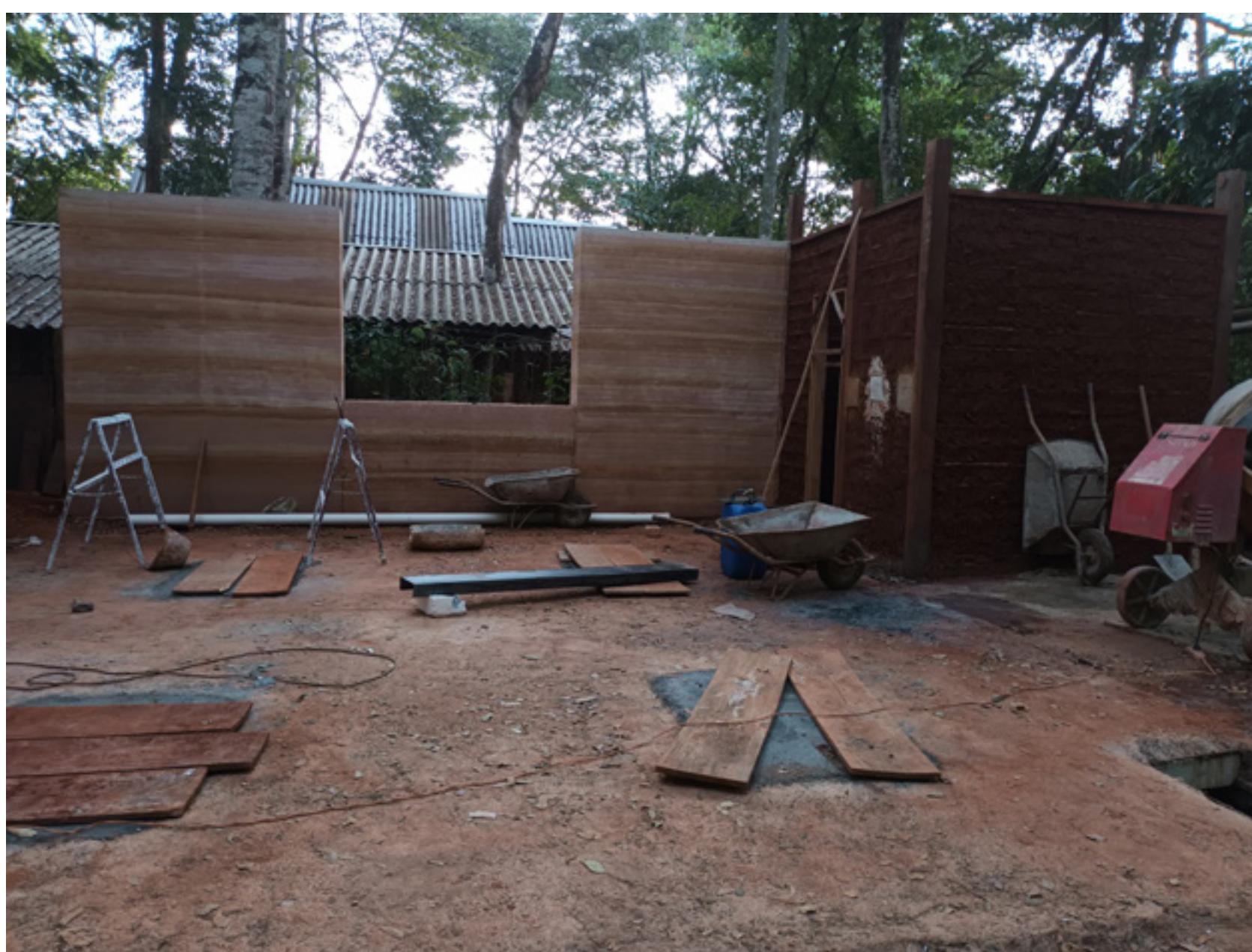
Figura 3. Obras de nova cozinha do Sertão Negro, de Dalton Paula, com parede em técnica construtiva de taipa de pilão. “Parede com baixa emissão de carbono, respira, então não tem mofo no ambiente”. E a construção ao lado de bambu a pique. Jun. 2023. Acervo pessoal.
